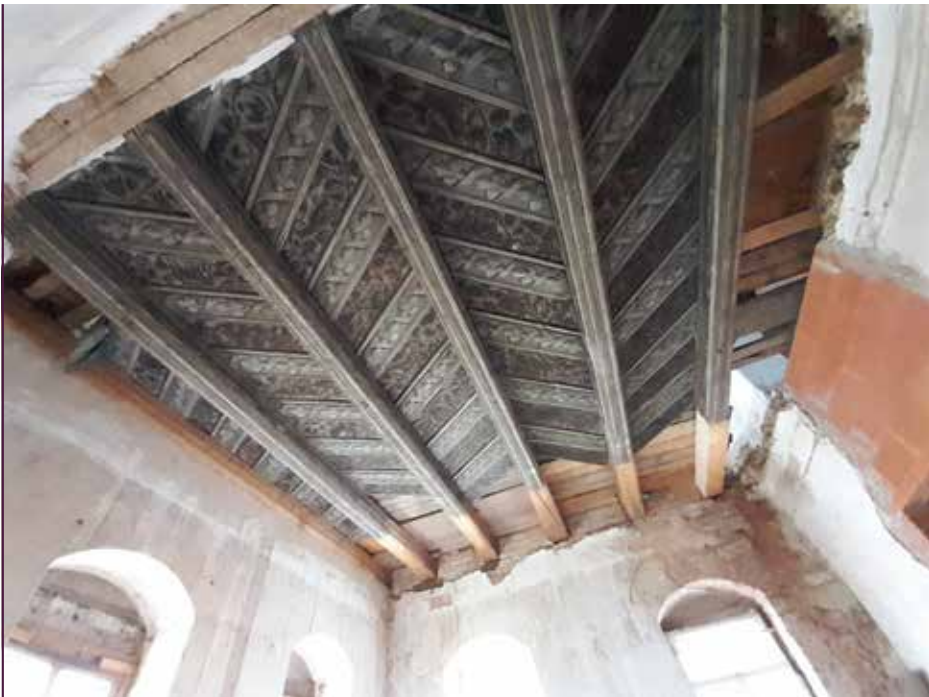
Bei den Sanierungsarbeiten wurden bemalte Renaissancedecken gefunden.
