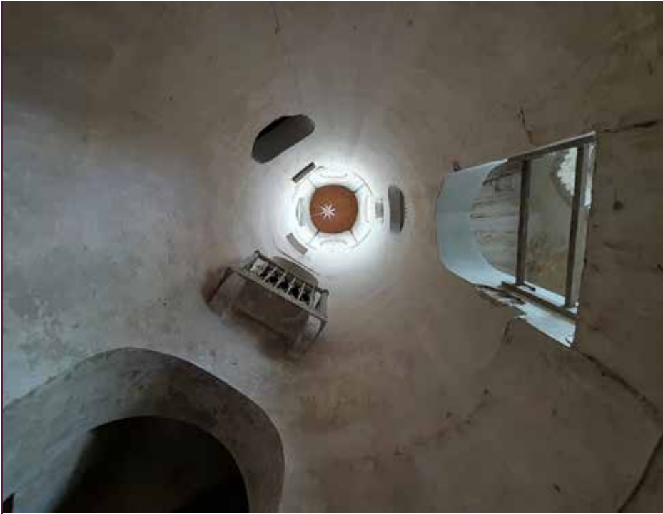
Der einstige Treppenturm dient seit dem 19. Jahrhundert als Lichtschacht.
