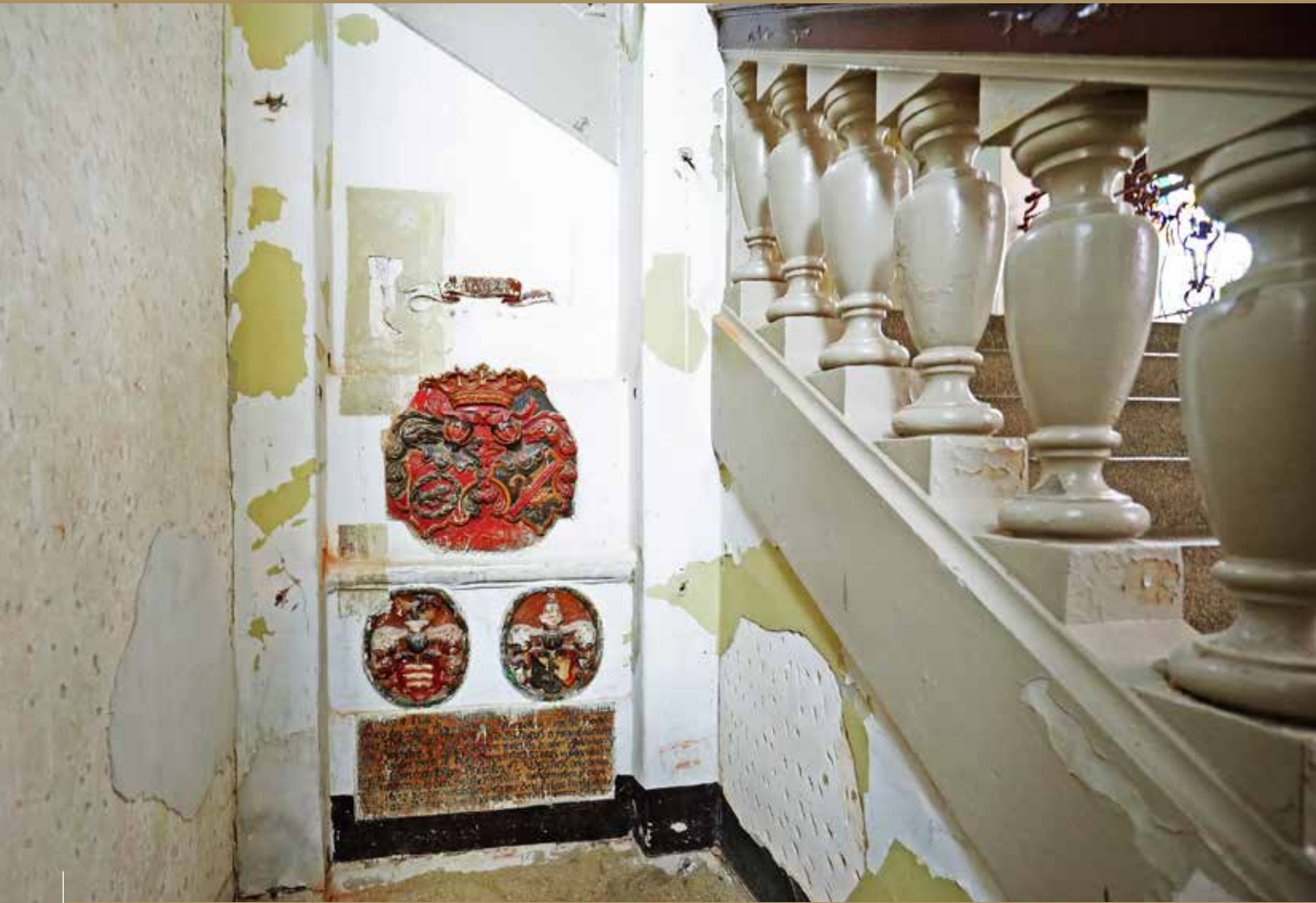
Das barocke Treppenhaus des Schlosses Hirschstein mit den Wappen, deren Restaurierung mit Spendenmitteln finanziert werden soll
