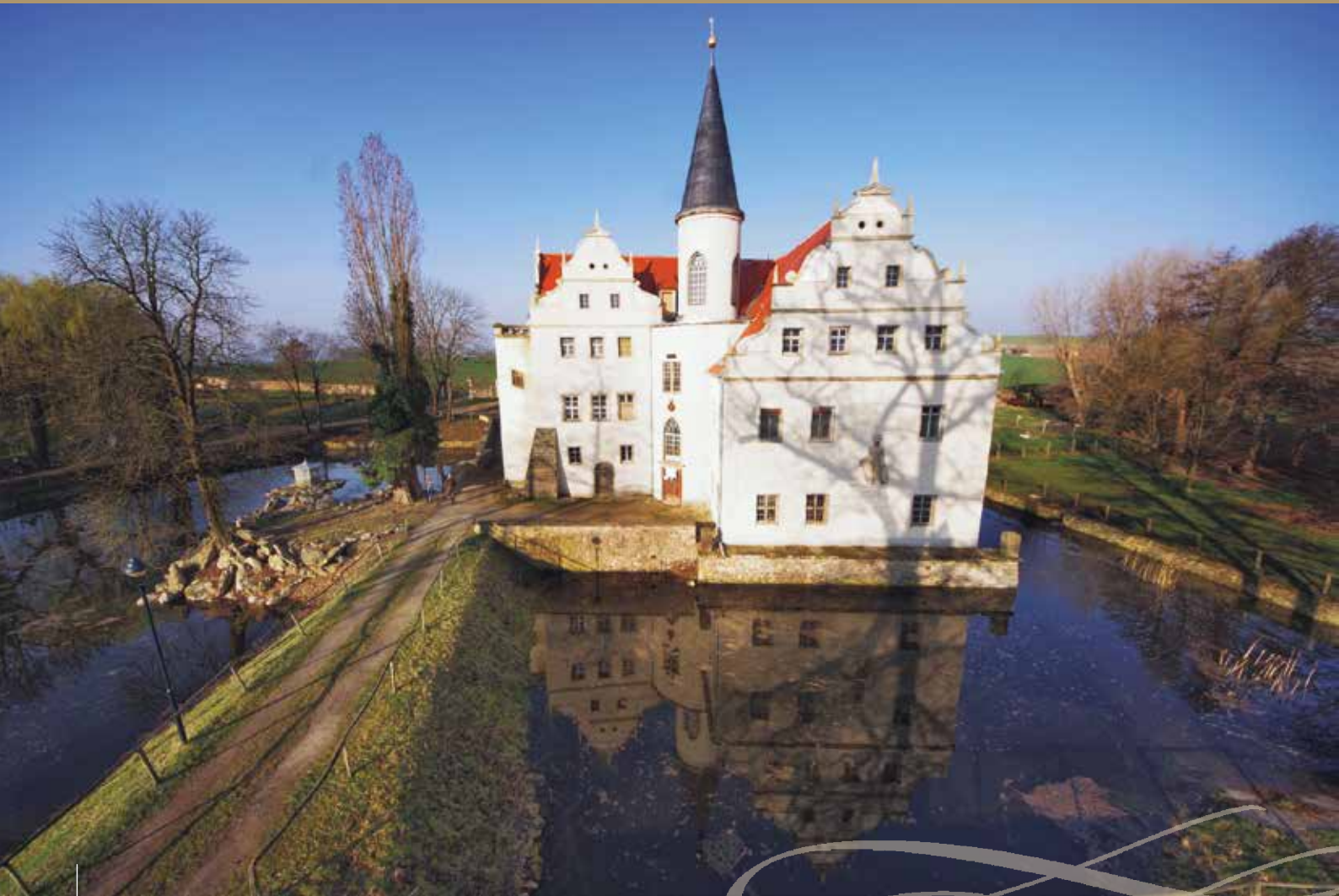
Schloss Oberau nach Dach- und Fassadensanierung mit wiederbefülltem Wassergraben, Sommer 2024
