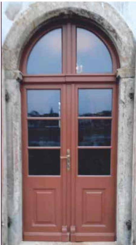
Neue Terrassentür des Schlosses Promnitz
