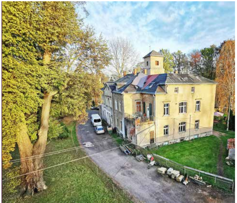
Schloss Pinnewitz hat in den letzten 80 Jahren stark gelitten. Dach und Fassaden benötigen eine Erneuerung.
