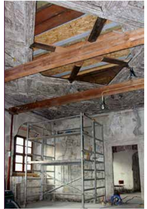
Freigelegte Renaissancedecke im ersten Obergeschoss des Lotterhofes
