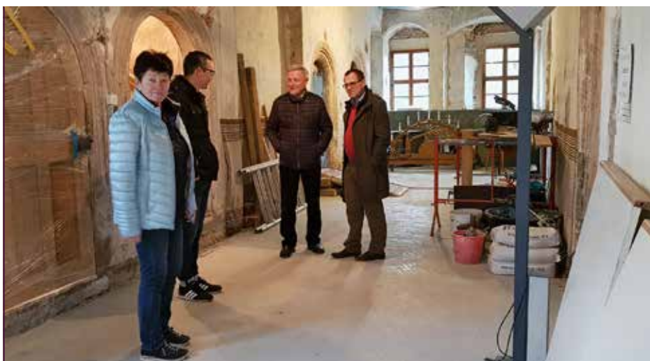
Auf der Baustelle: Dr. Matthias Donath im Gespräch mit Dietmar und Christine Meyer und dem Architekten Dirk Trommer
