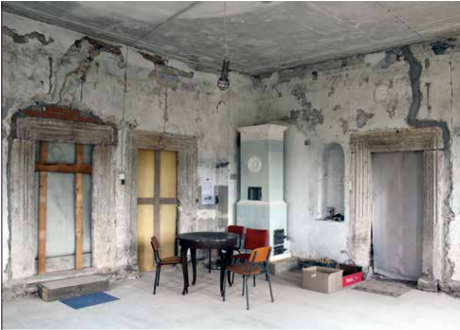
Noch unsanierteter Bereich im Inneren des Lotterhofes
