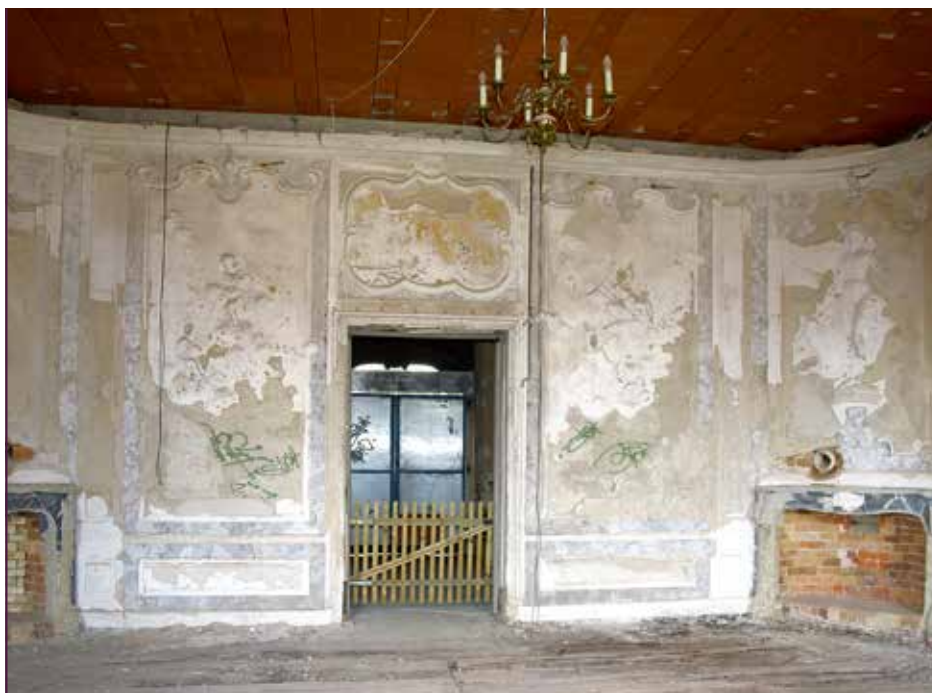
Reste der barocken Wandgestaltung im Erdgeschoss
