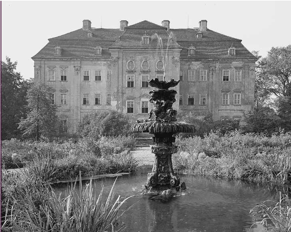
Schloss Tiefenau: Das barocke Schloss wurde 1948 gesprengt.
