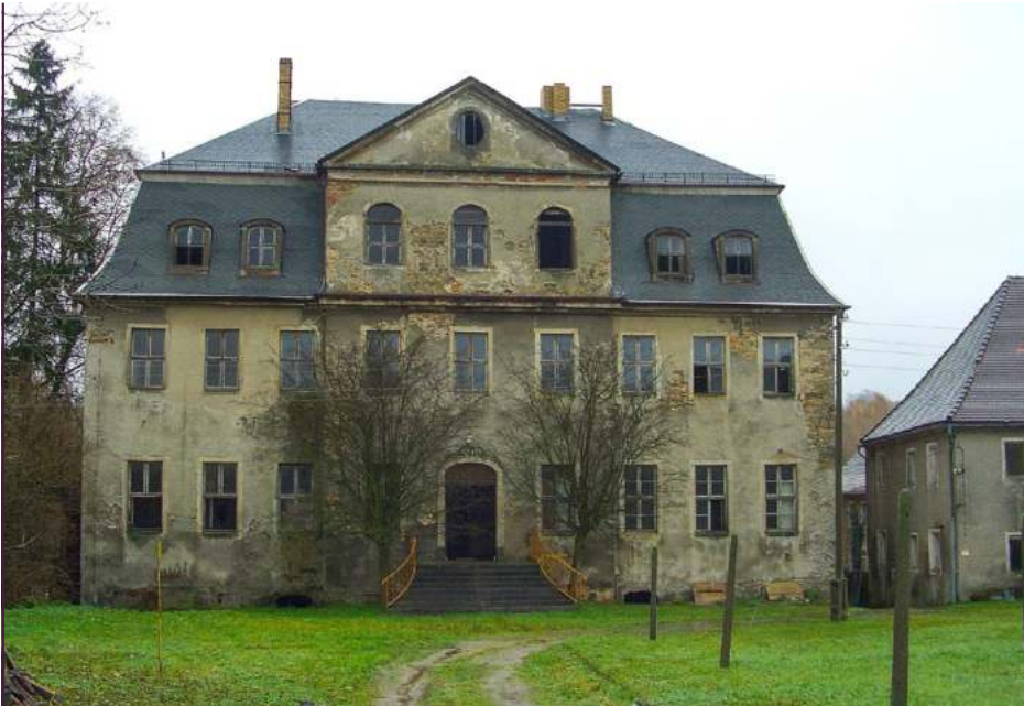
Schloss Schmölln im Jahr 2008 – noch vor dem Einsturz mehrerer Dachgauben
