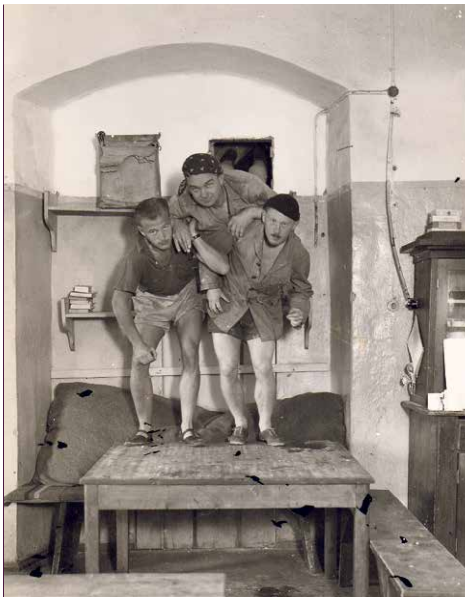
Wanddurchbruch im Schloss Colditz, 1941
