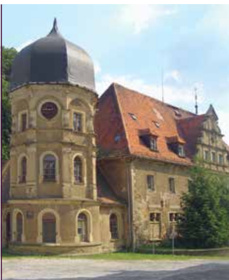
Das Kleine Schloss ist bisher noch nicht saniert worden
