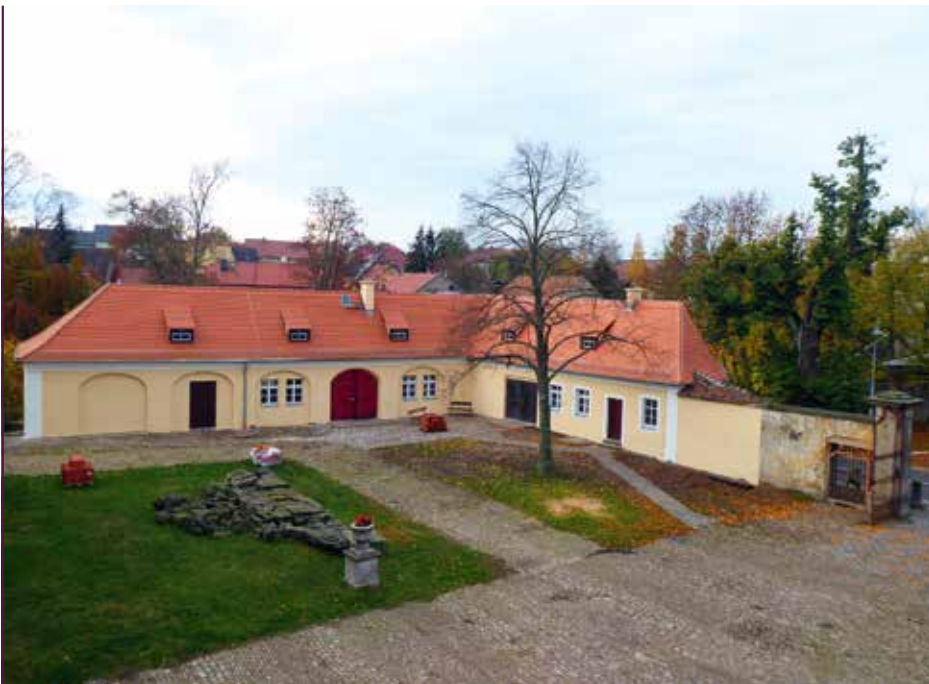
Nebengebäude des Schlosses, das vollständig restauriert wurde
