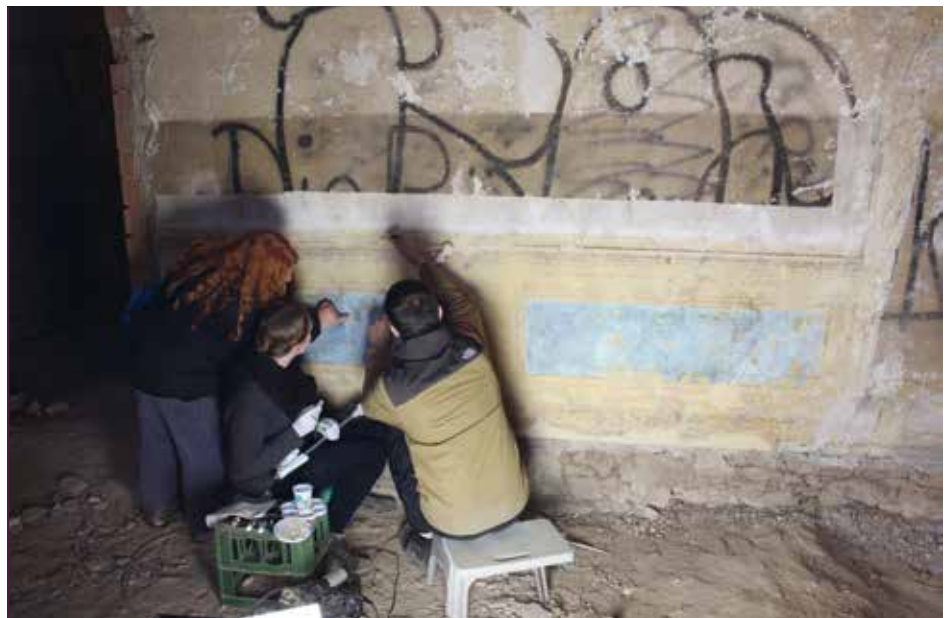
Restauratorin Anja Romanowski erklärt den Studenten am praktischen Beispiel die Vorgehensweise – die Wand offenbart zwischen Graffiti und bis zu vier Farbschichten manches Geheimnis.
