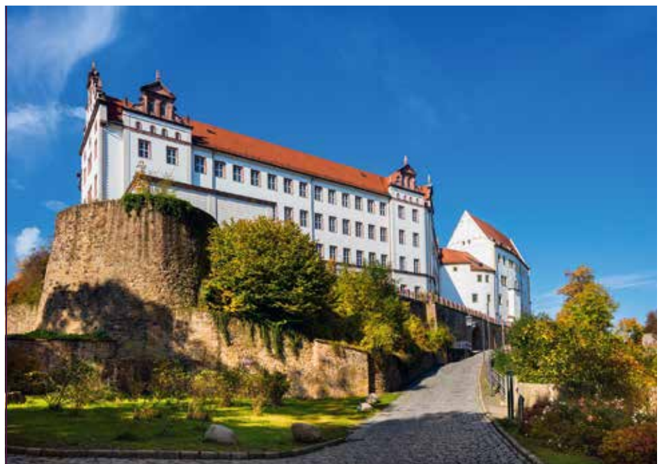
Schloss Colditz, Südansicht. Das Gebäude im Vordergrund ist heute Jugendherberge und war während des Zweiten Weltkrieges Deutsche Kommandantur.
