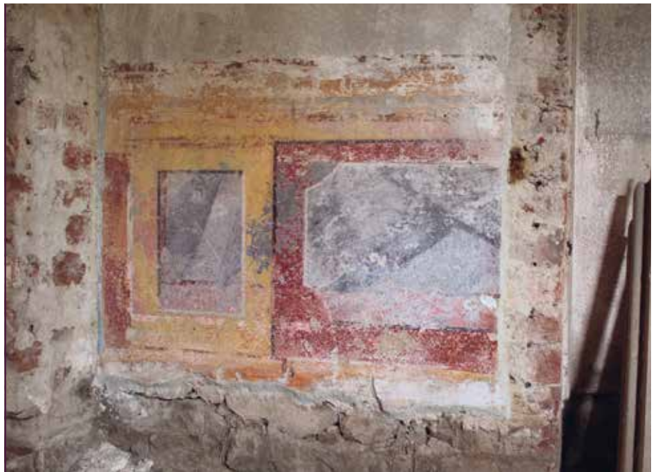
Die freigelegten Marmorierungen und Muster lassen die ursprünglich barocke Fassung der Wandgestaltung erahnen.
